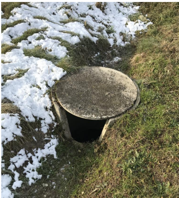
Slika 7: Betonski jašek in vtok v prepust v km 3.5+70.00
